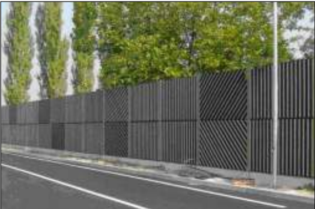
Esempi applicativi di barriere antirumore in legno.
